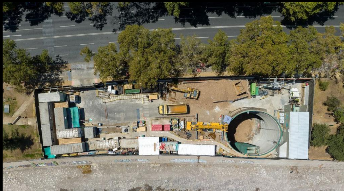
Pique de construcción 12 – Línea 7
