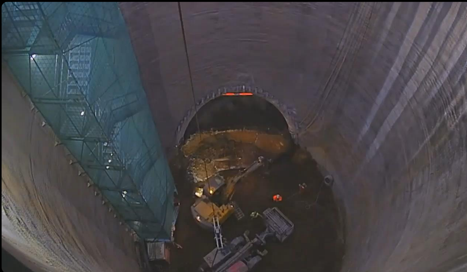
Construcción de Extensión de Línea 2 durante años 2020
