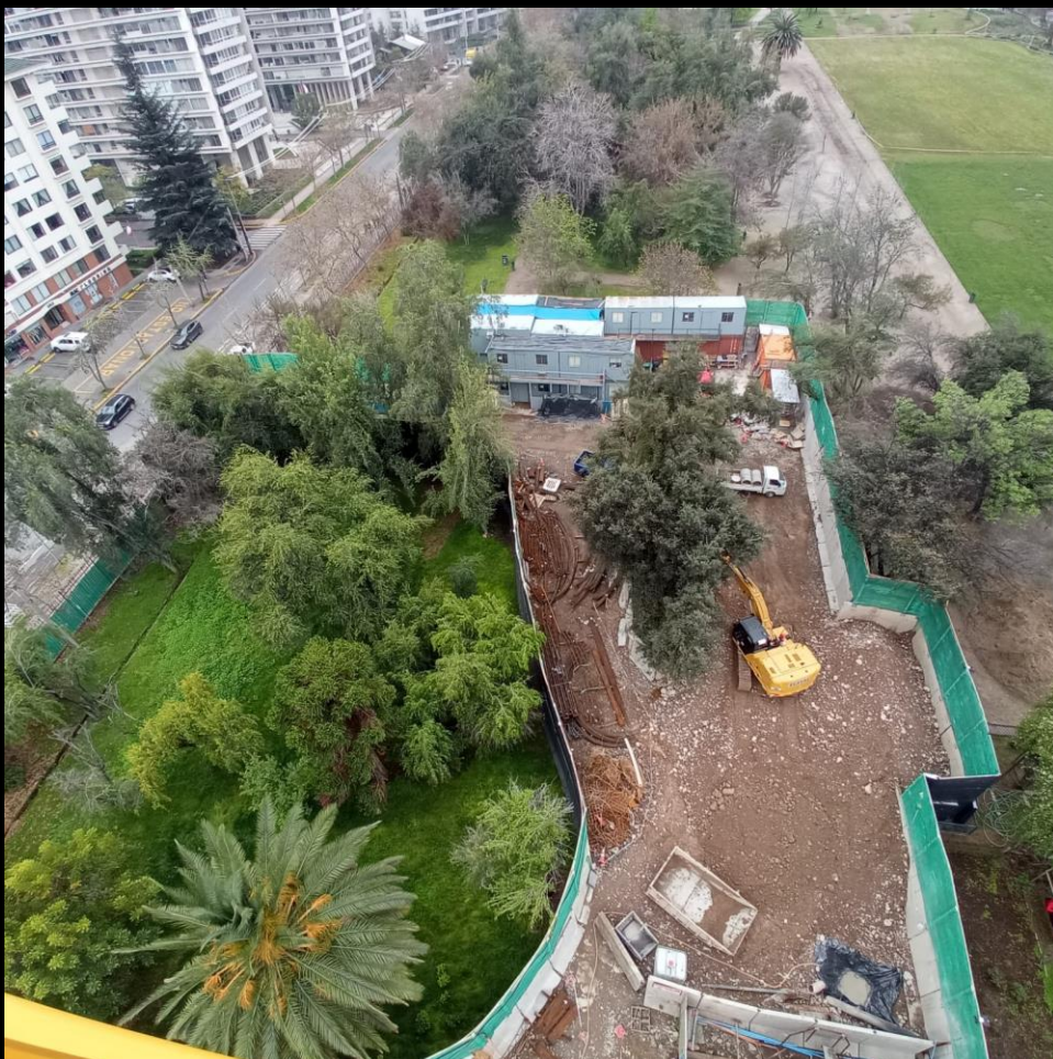
Pique de construcción Estación 16 – Línea 7
