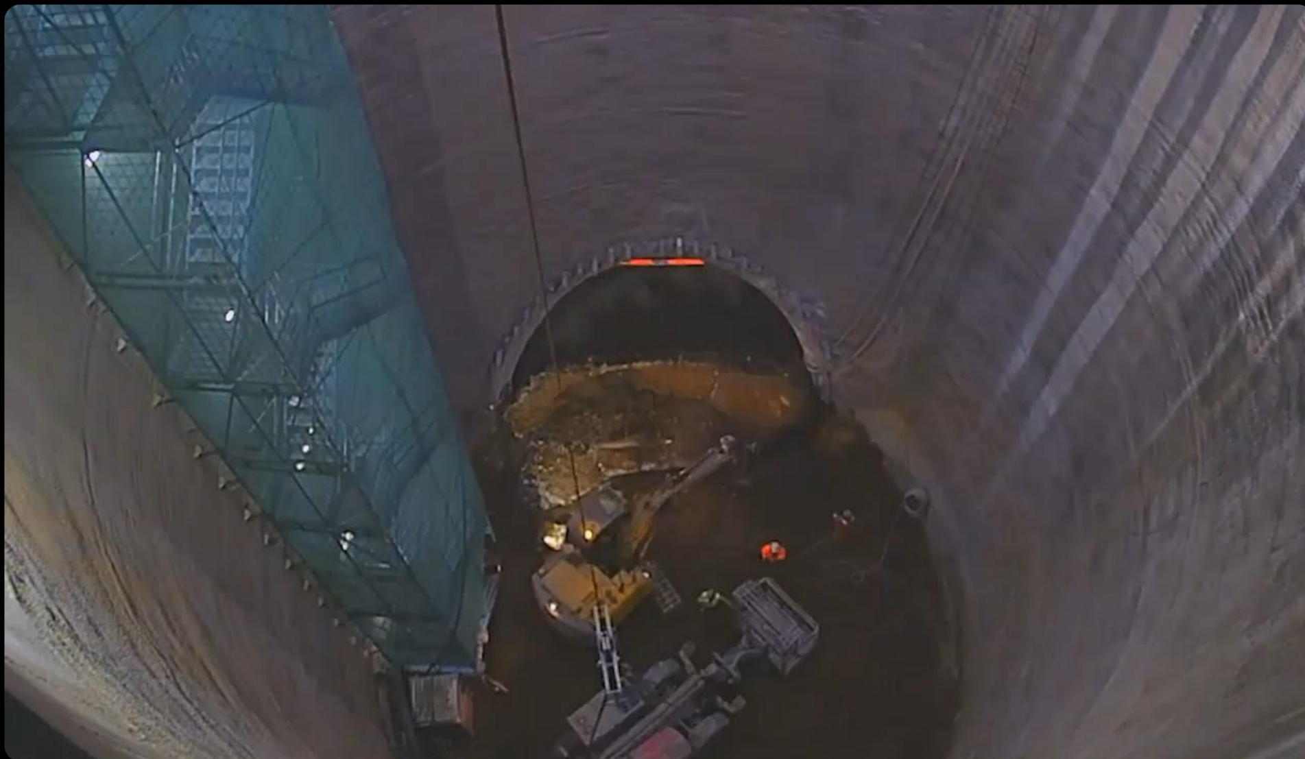
Construcción de Extensión de Línea 2 durante años 2020
