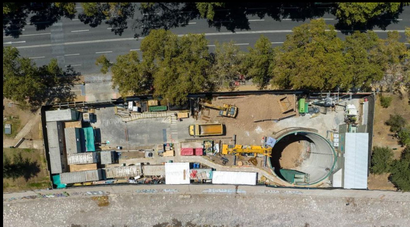
Pique de construcción 12 – Línea 7
