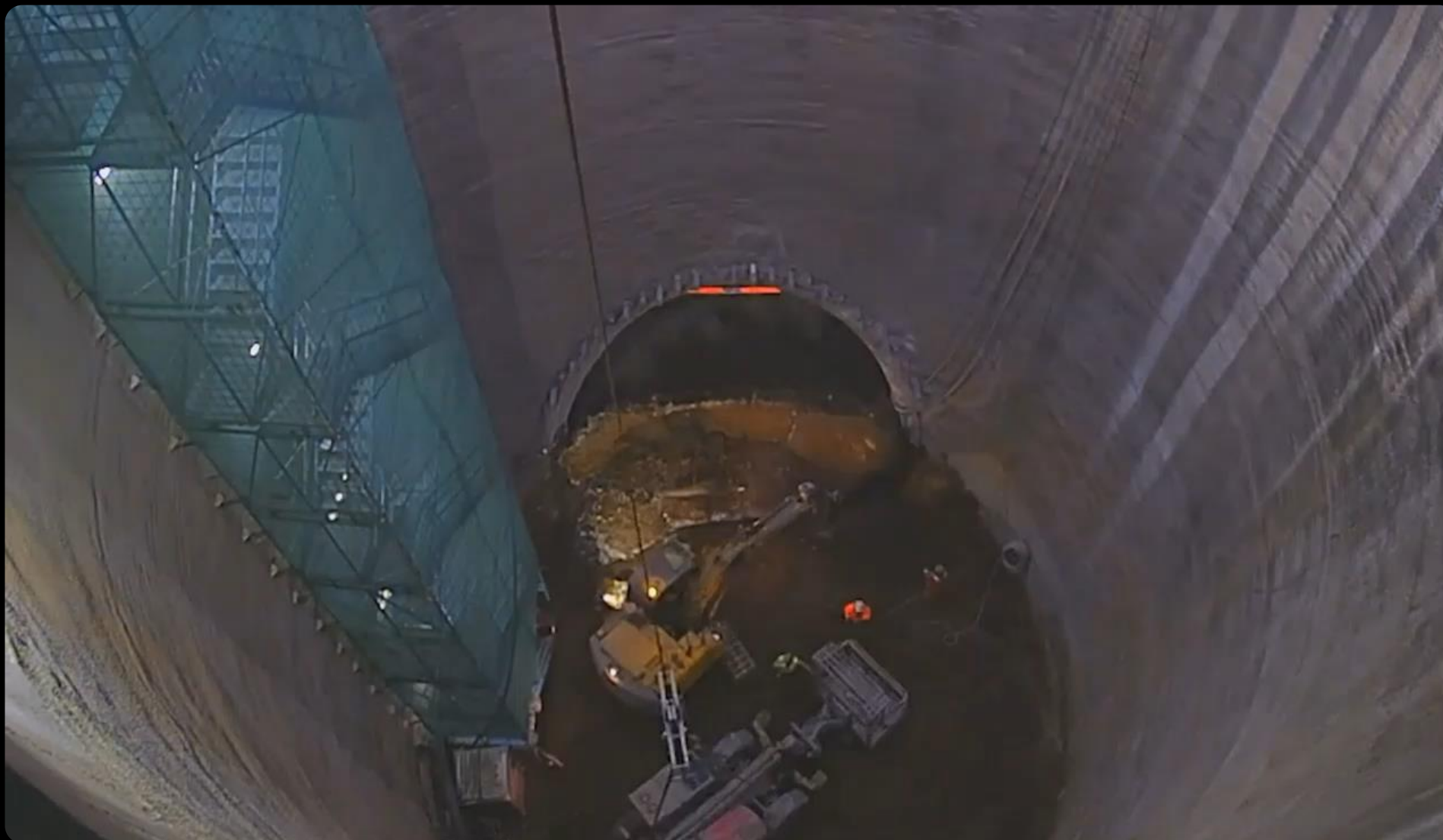
Construcción de Extensión de Línea 2 durante año 2020
