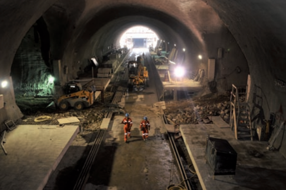
» Avance en obras de extensión de Línea 1.
