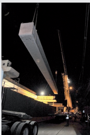
» Colocación de la primera viga del viaducto del nuevo tramo de Línea 5.
