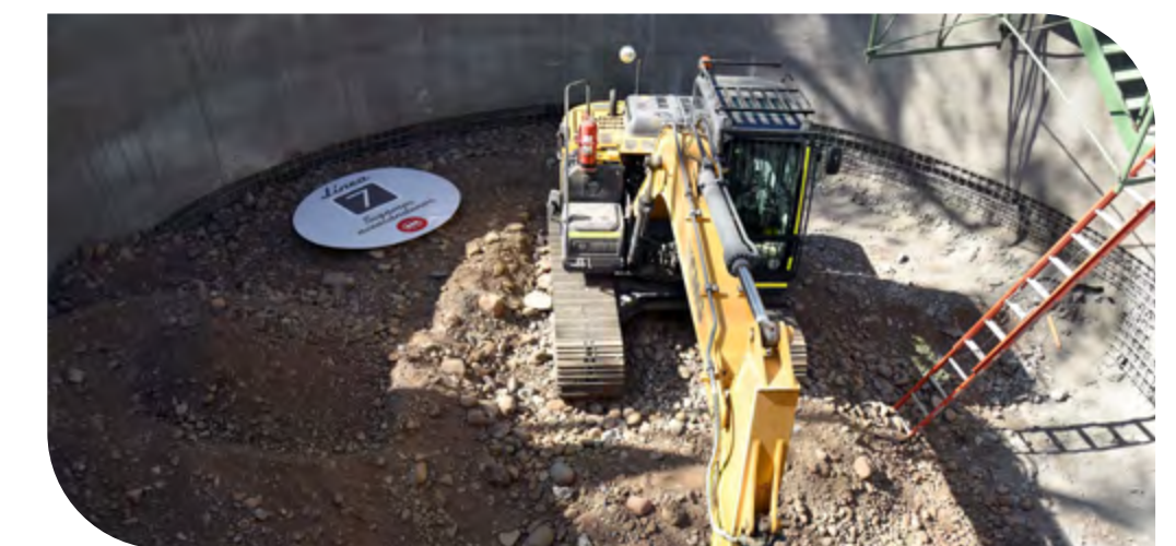
Inicio excavaciones Línea 7
