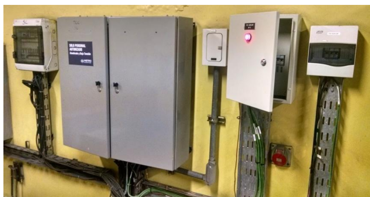
Fig 1. TCC y tableros auxiliares en locales técnicos.
