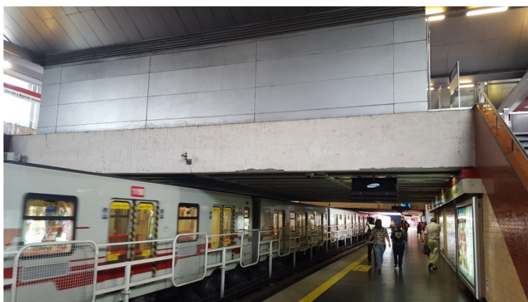
Limpieza, empastado y pintura de vigas por el interior y exterior.
