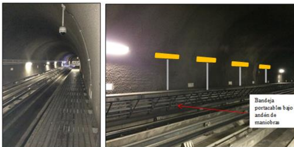
Ilustración 5 Andén de maniobras vía 2. Imagen referencial de ubicación de equipos con su canalización.
