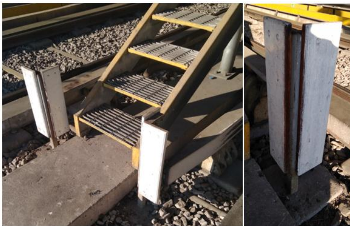
Ilustración 11: Punteras que se encuentran instaladas en Taller Lo Ovalle
