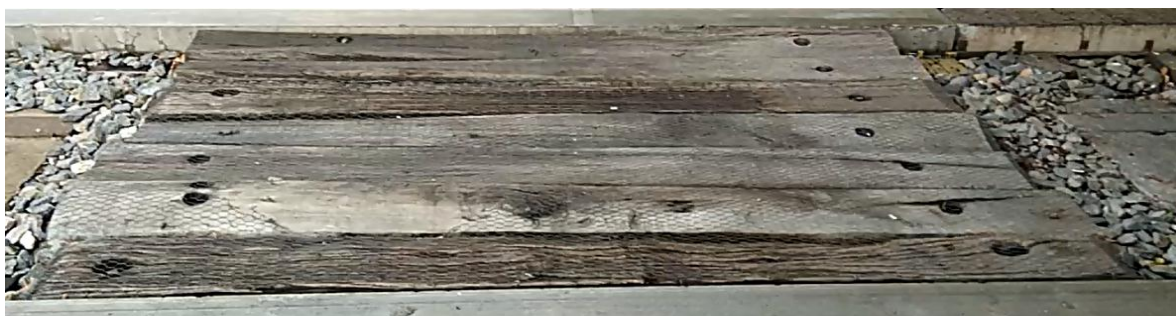
Ilustración 3: Área tipo 2. Son las áreas que separan las vías. Los tabloncillos están sobre balasto.
