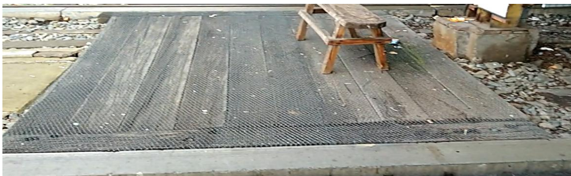
Ilustración 4: Área tipo 3. Zona central del pasillo principal. Es de tabloncillos sobre balasto.
